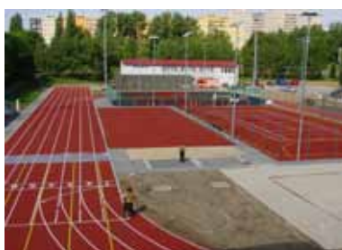
2009 víceúčelové hřiště, Ostrava Retoping WS - 785 m 2
